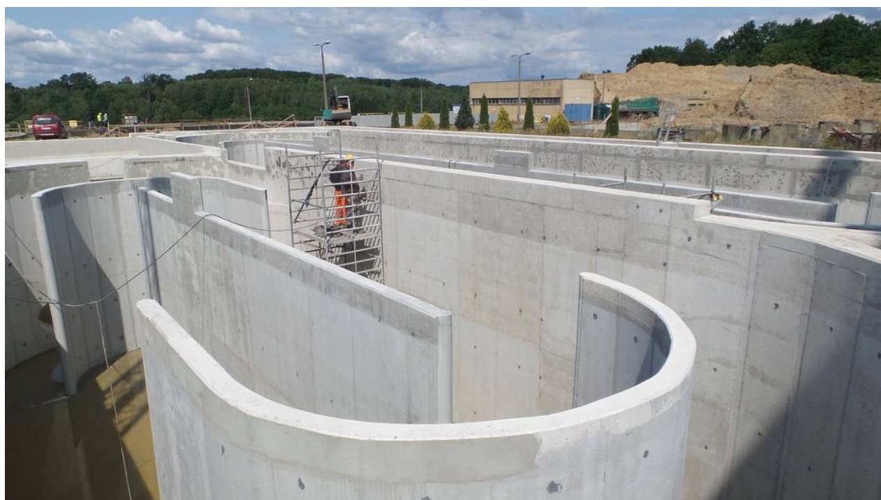
Obiekt nr 21 – reaktor biologiczny.
