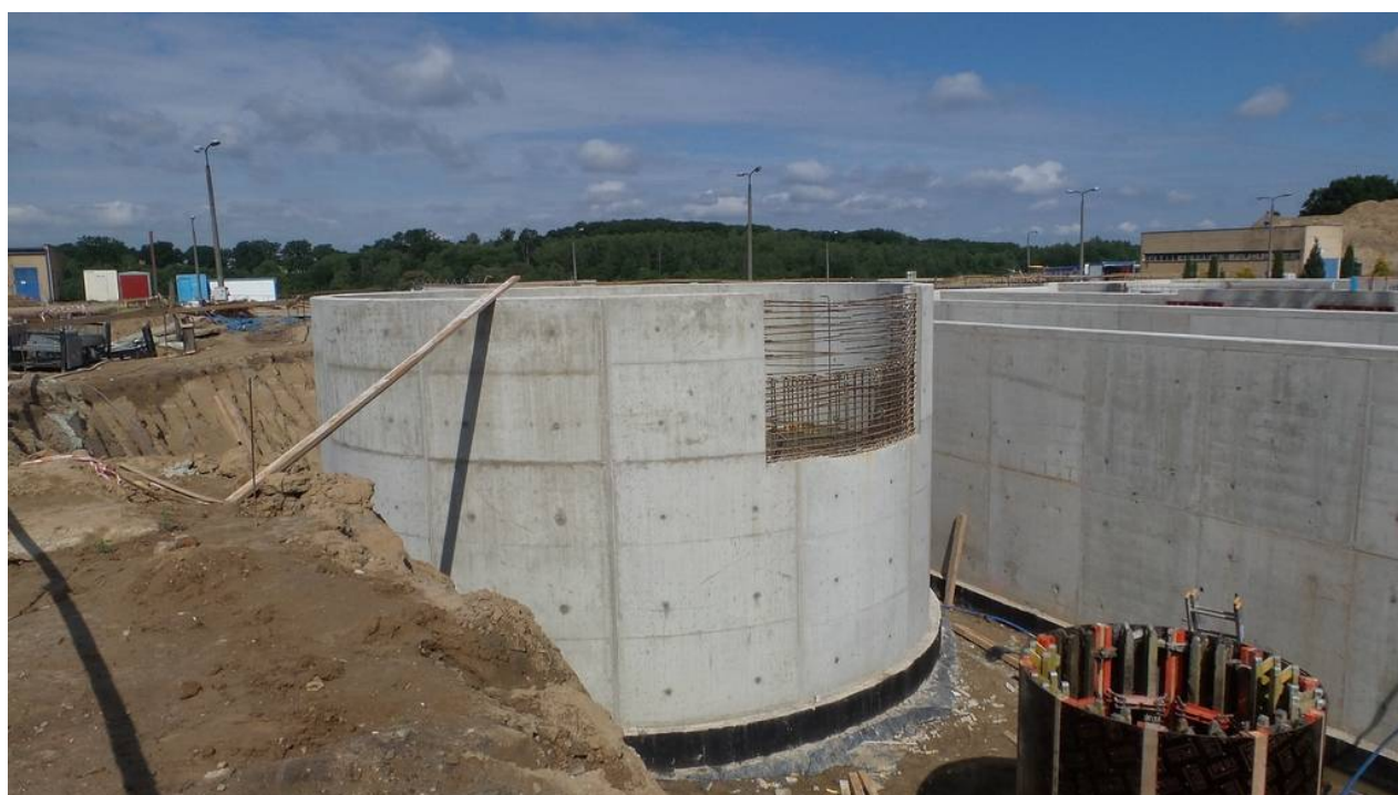
Objekt nr 23 – Komora rozdziału przed reaktorami.
