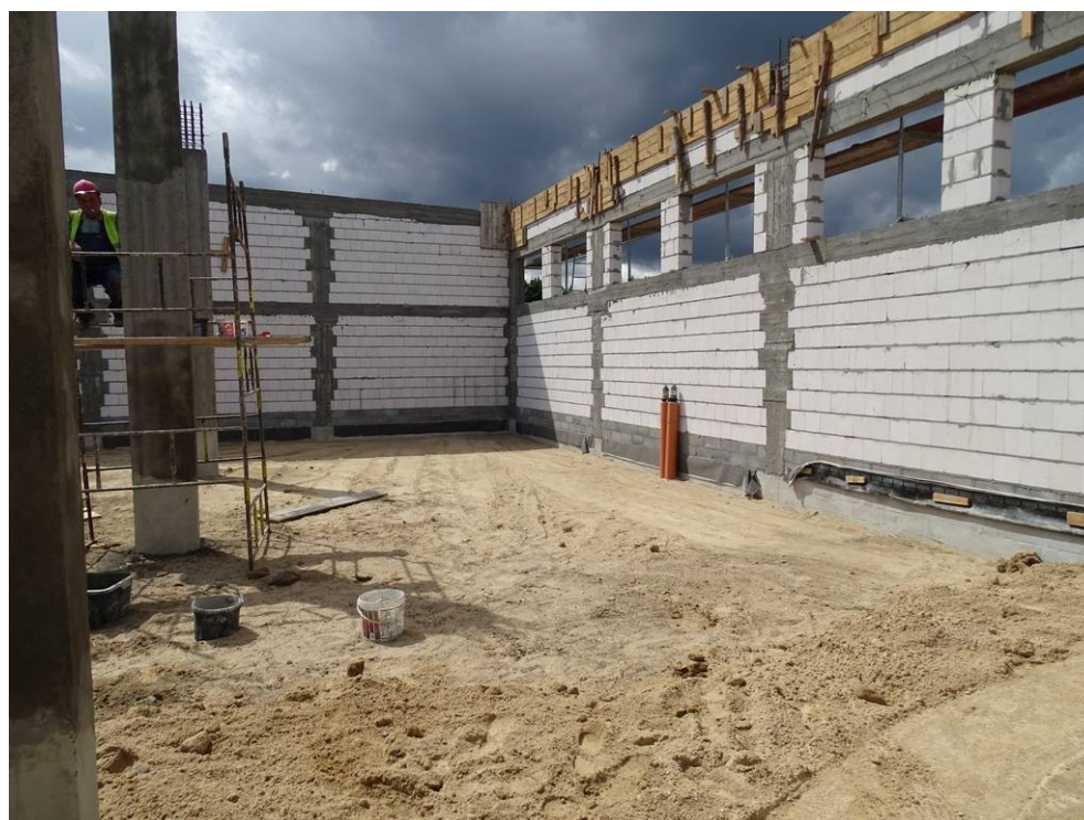
Obiekt nr 3 – garaże.
